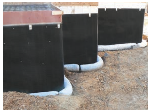
Защита гидроизоляции и дренаж
