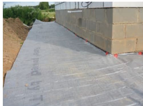
Дренаж в отмостке
