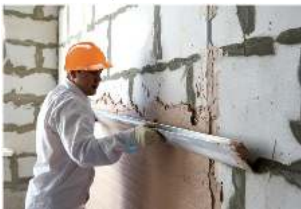
Рисунок 5 – Разравнивание поверхности h-образным правилом
