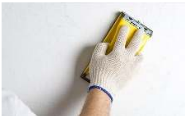
Рисунок 8 – Затираание губчатой теркой
