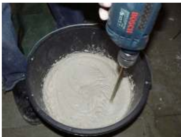
Рисунок 3 – Приготовление штукатурного раствора
