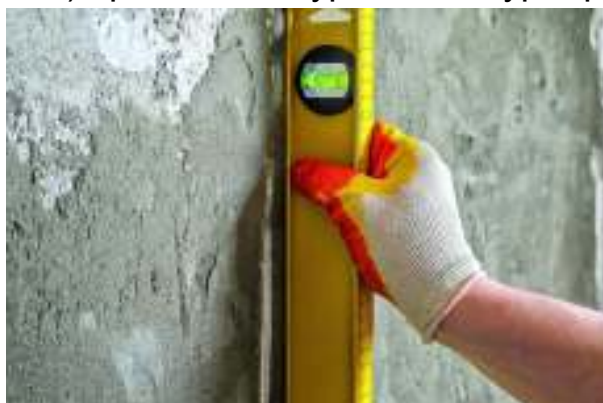
Рисунок 6 – Проверка предварительного разравнивания
