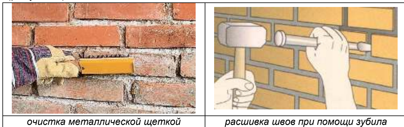
Рисунок 1 – Подготовка кирпичных стен
