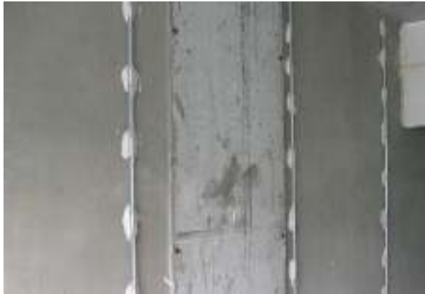
Рисунок 4 - Установленные «маячковые» профили
