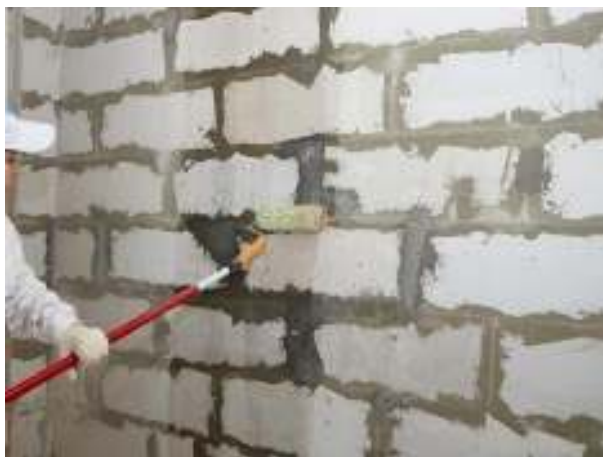
Рисунок 2 – Грунтование поверхности
