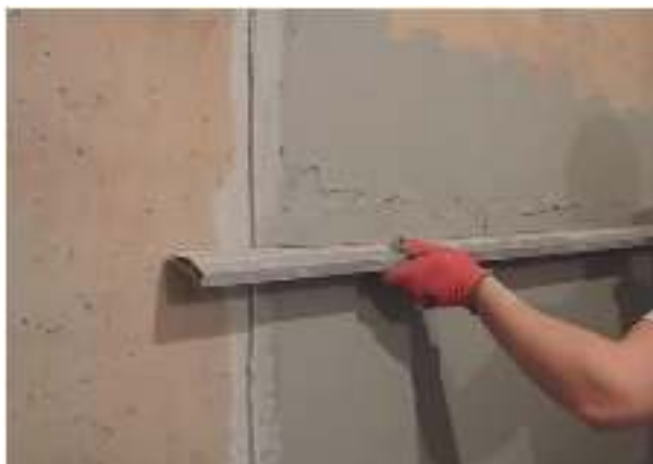
Рисунок 7 – Подрезка штукатурного слоя трапецевидным правилом
