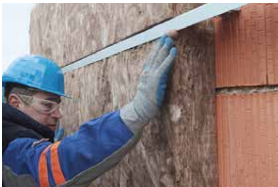
Реконструкция школы, г.Нижний Новгород
