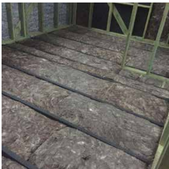
Перекрытие каркасного дома, Ленинградская обл.
