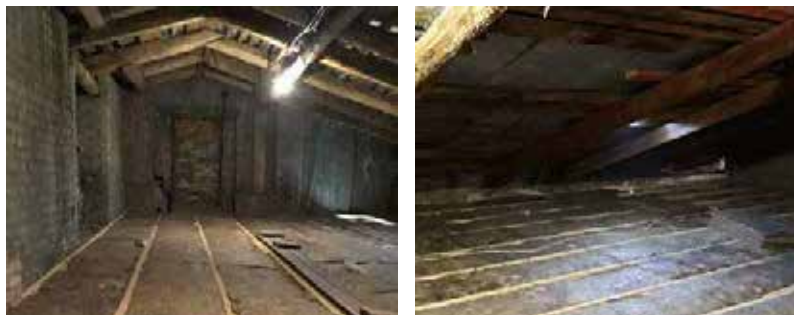
Реконструкция чердачных перекрытий, г. Вологда
