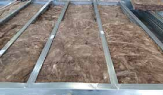
Производство модульных домов "Новый дом", г.Красногорск
