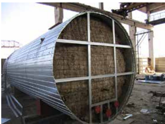
Резервуар для хранения топлива, г. Тула
