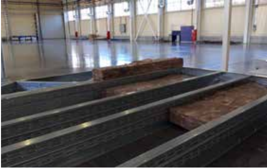
Производство модульных домов "Новый дом", г.Красногорск
