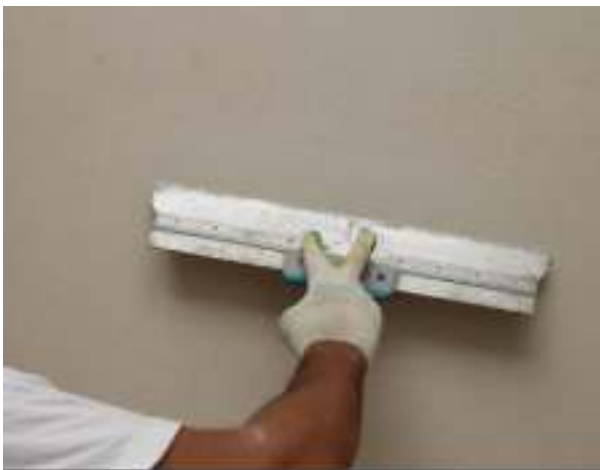
Рисунок 16 – Шпатлевание поверхности
