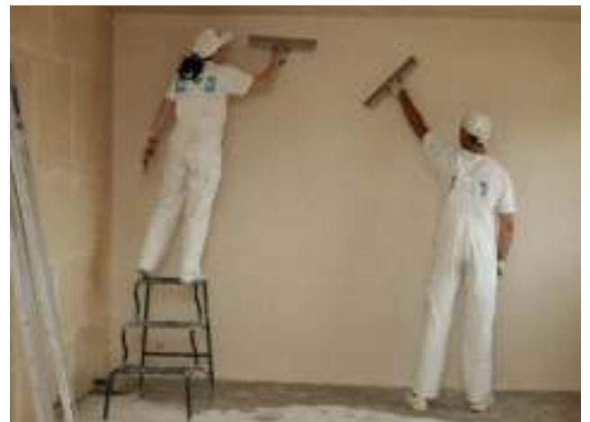
Рисунок 16 – Шпатлевание поверхности
