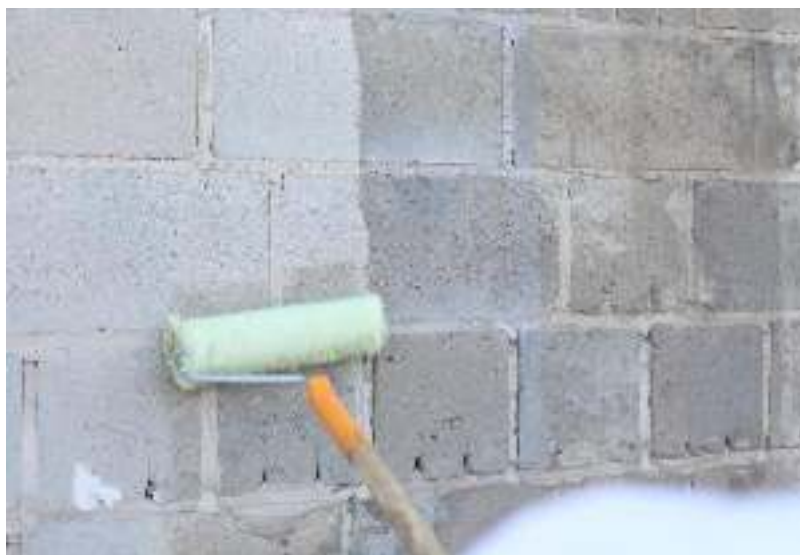
Рисунок 5 - Грунтование поверхности
