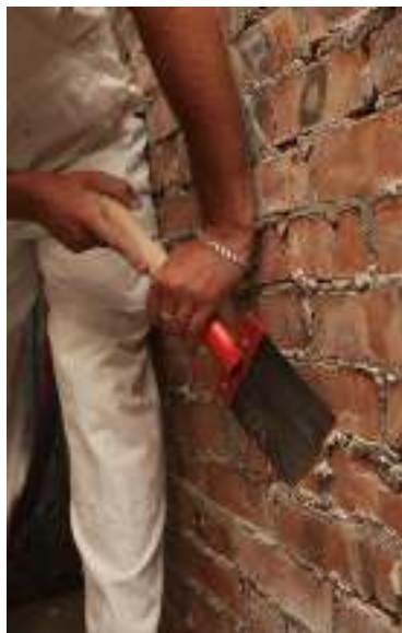
Рисунок 4 - Очистка поверхности основания
