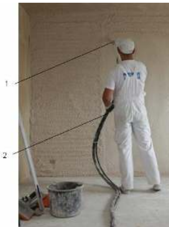
1 – растворный распыляющий пистолет штукатурного агрегата; 2 - раствороподающий рукав штукатурного агрегата
