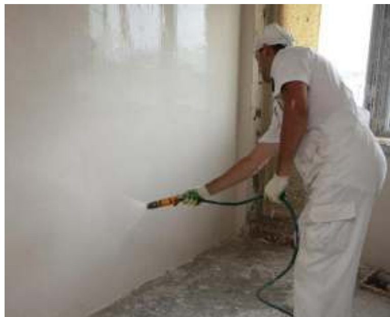
Рисунок 14 - Смачивание поверхности водой из распылителя
