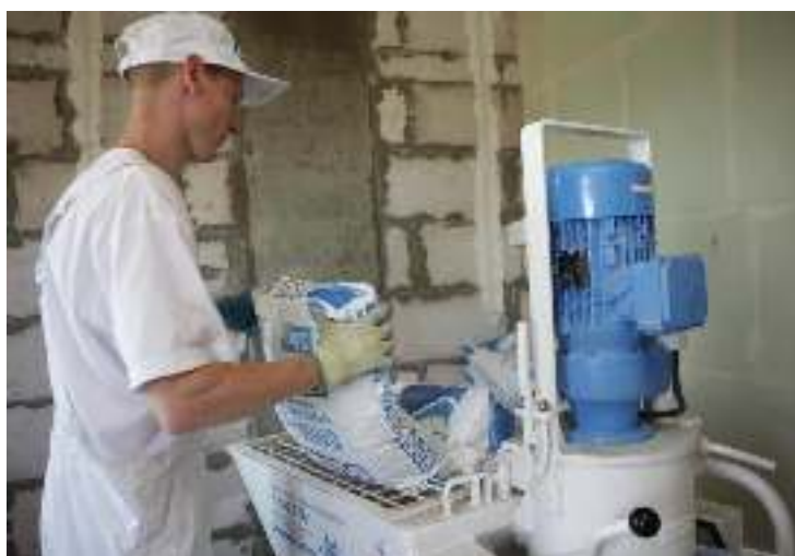
Рисунок 6 – Приготовление штукатурного раствора
